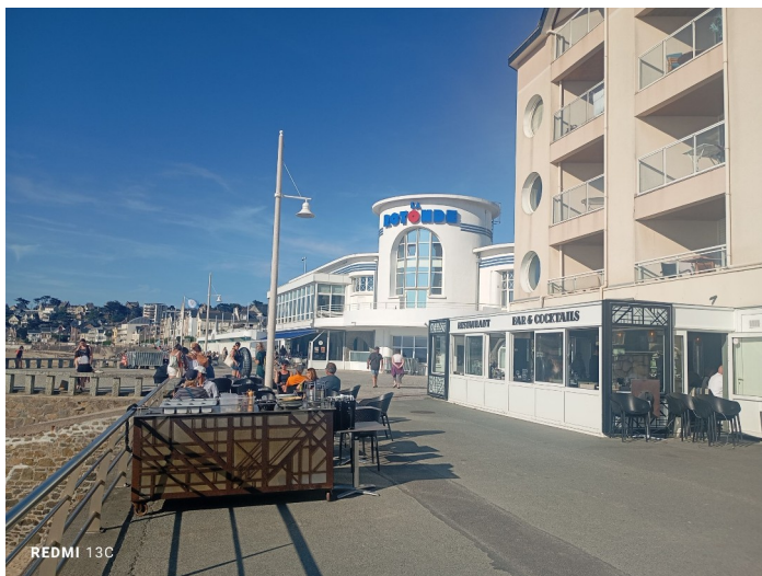
Figure 53 : photographie des restaurants « la Rotonde » et « la Croisette » sur la Digue, Pléneuf Val-André, Maxime Le Duc, Atlantic Sunset
